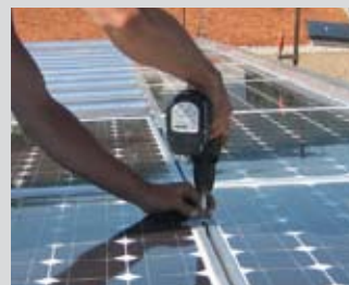
Verschrauben der Klemmplatte im Gewindekanal von KLEMENS XL
