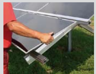
Module einlegen – fertig
