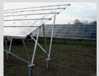
Aufbau mit vorgefertigten Elementen
