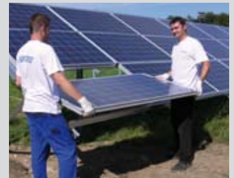
Einlegen von gerahmten Modulen
